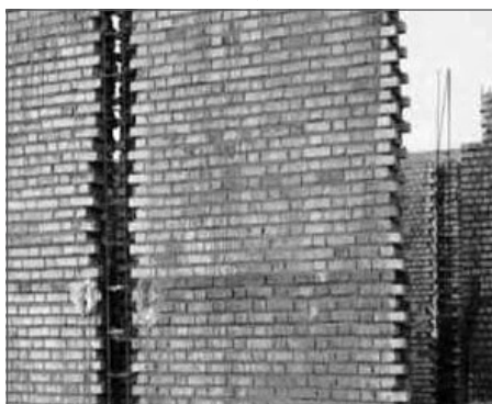
تصویر ۲۵: کلاف قائم در دیوارهای محوطه
