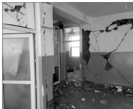
تصویر ۳۵: نمونه از کیفیت بتن در روستای زلزله زده سیا آب
