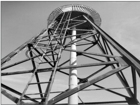
تصویر ۷: سازه فلزی در روستا وردک‌ها ولسوالی زنده جان تصویر ۸: موجودیت بادبندهای ضربدری در سازه فلزی
