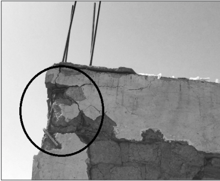
تصویر ۲۲: رد کردن میلگردهای سراسری تیر از میلگردهای ستون
