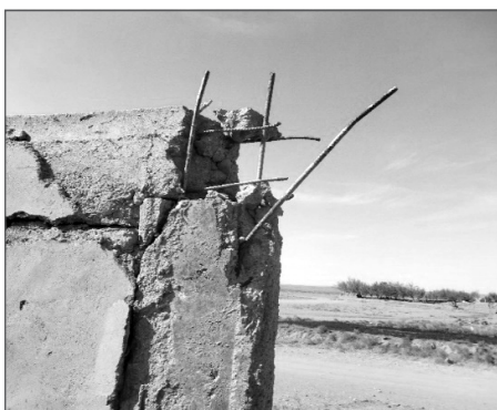
تصویر ۲۰: نداشتن قلاب ۹۰ درجه میلگرد های تیر داخل ستون
