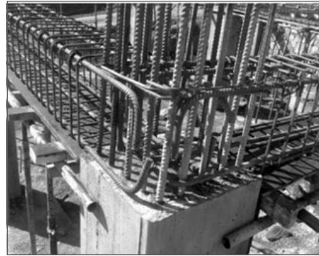
تصویر ۲۱: رد کردن میلگردهای سراسری تیر از میلگردهای ستون
